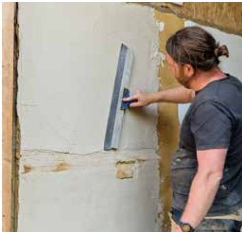
Das Aufbringen von verschiedenen Lehmputzen will geübt sein.
